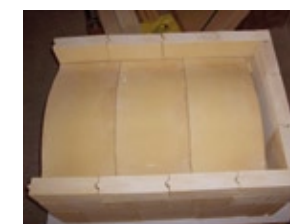
Durchbrandöffnung hinten ca. 4 bis 5 cm
